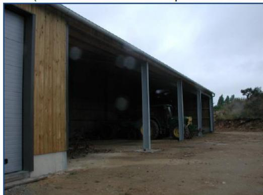
Auvent (débord de toiture avec encorbellement)
