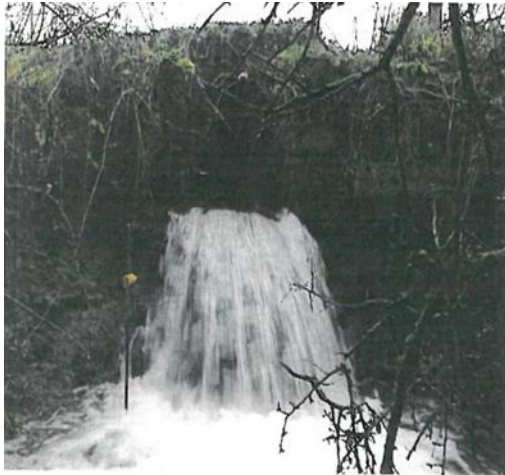
Sortie de la buse : chute d'environ 1 mètre
